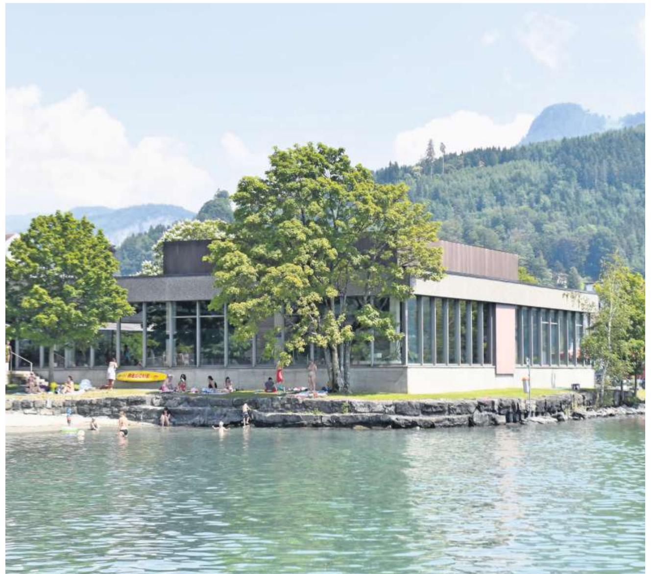
Das Hallenbad in Brunnen muss dringend saniert werden.
