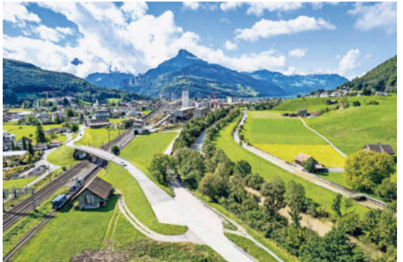
An dieser Stelle an der Seewenstrasse soll der Hochkreisel oder die Kurve+ gebaut werden.
