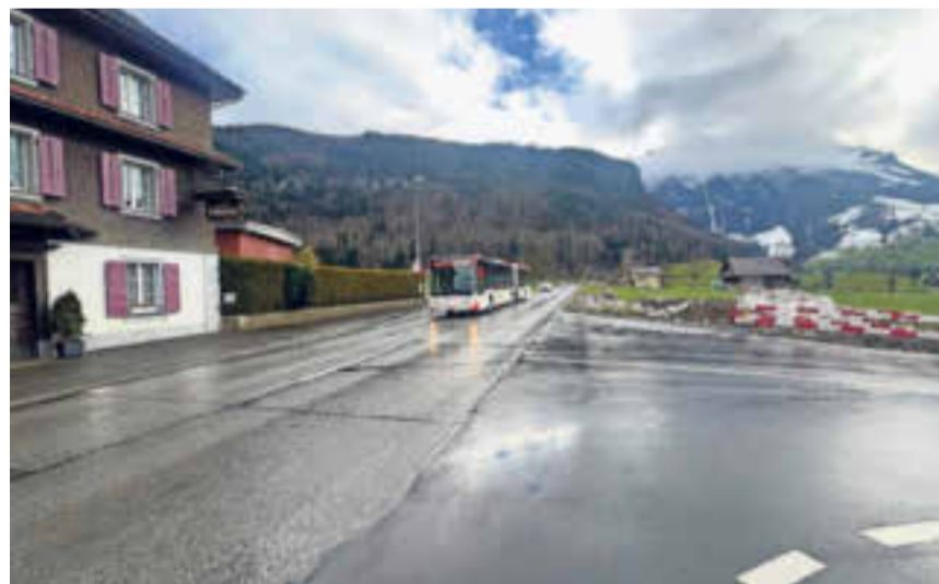
Ab hier wird neu ein Trottoir Richtung Muotathal gebaut.
